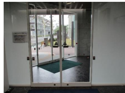
1号館 ANNEX1階自動ドア
