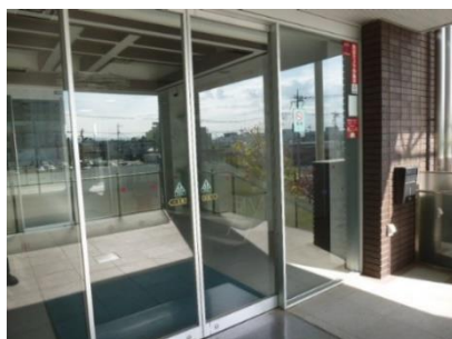
1号館2階自動ドア
